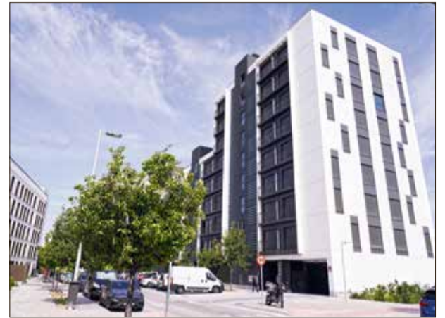
▲ La Rosilla 1, la promoción de viviendas municipales recién entregada
