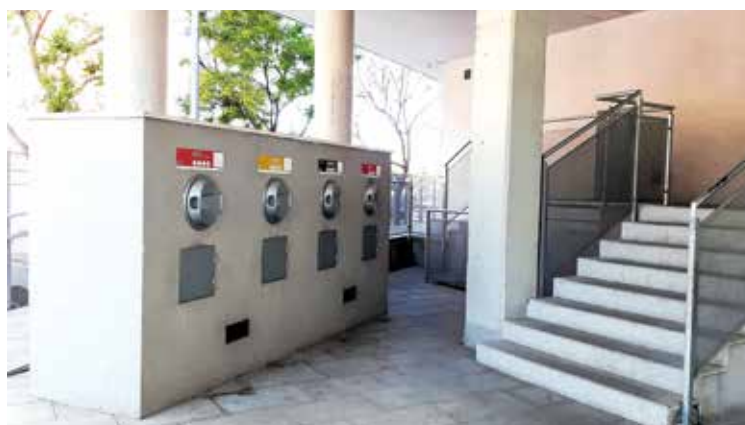
▲ Las compuertas de vertido en la entrada de uno de los edificios de viviendas del ecobarrio
