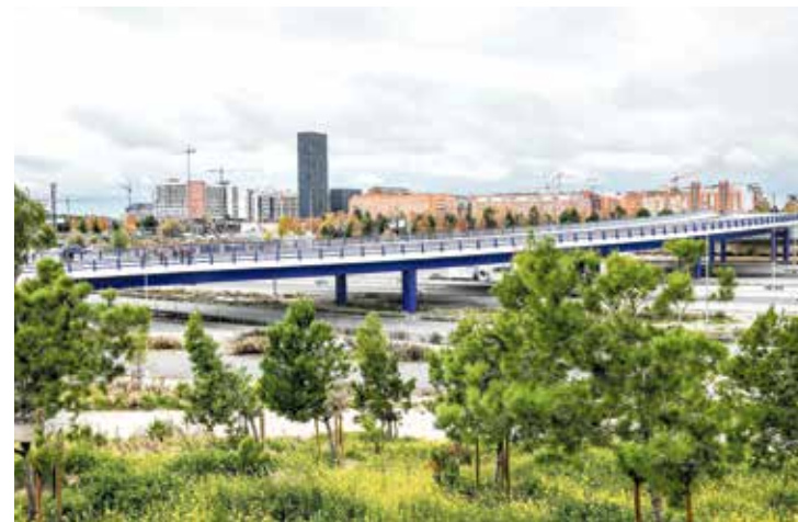
▲ Uno de los puentes recientemente abiertos
