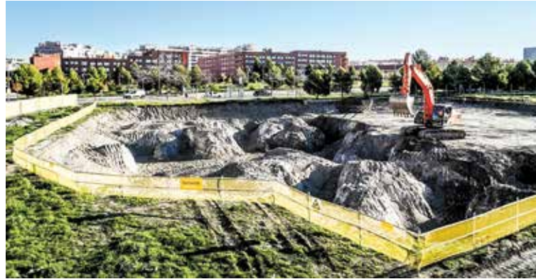
Una excavadora trabaja en la construcción del centro cultural
