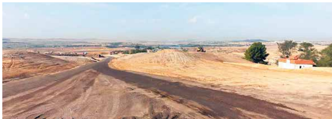
▲ Las obras que se están realizando en el sector 6 de la antigua vía pecuaria
