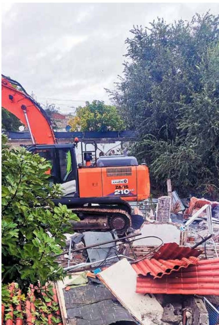
▲ El derribo de una de las viviendas levantadas en la antigua vía pecuaria
