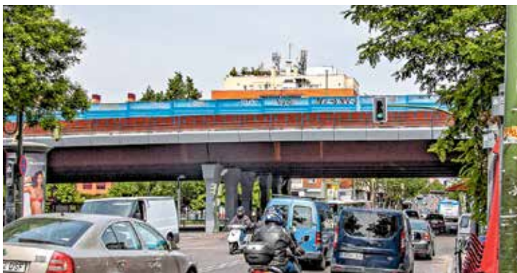
▲ La avenida de la Albufera, con el paso elevado de la M-30 en el horizonte JESÚS INASTRILLAS
