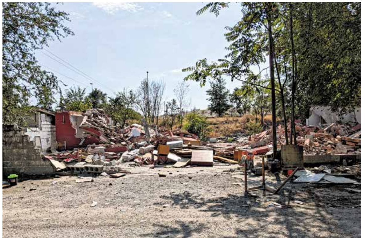
▲ Los escombros de una vivienda derribada hace poco tiempo
