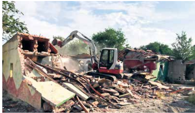
▲ Una excavadora derriba una vivienda de Cañada, en una imagen de archivo
