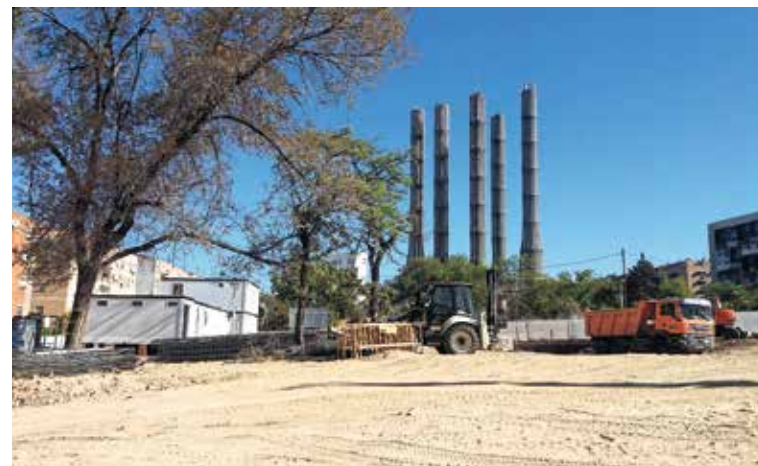
▲ Las obras de una de las promociones del 'ecobarrio'
