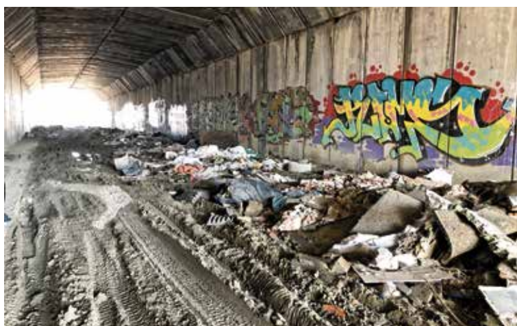
Estado actual del túnel
