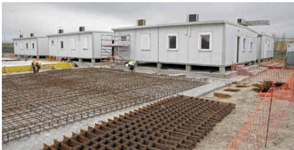
Las obras de construcción del centro de refugiados
