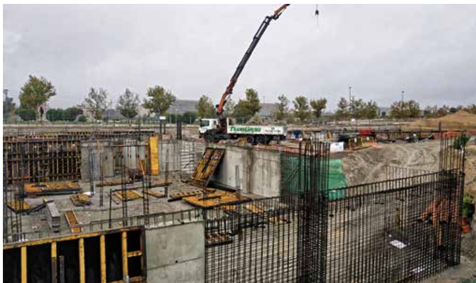
Los trabajos de construcción del polideportivo del Ensanche de Vallecas
