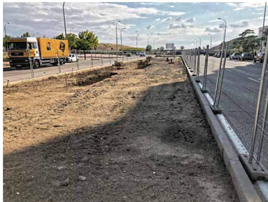
La mediana de la avenida de la Gavia en obras.
