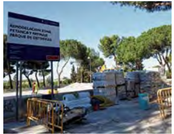
Un momento de las obras
