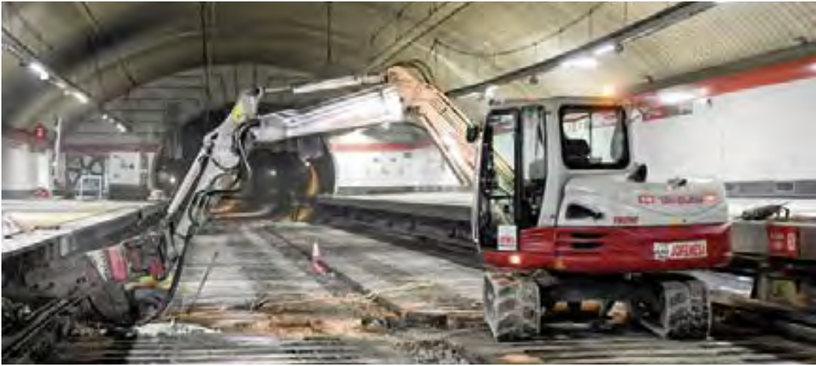
Los trabajos en el interior del túnel de Recoletos
