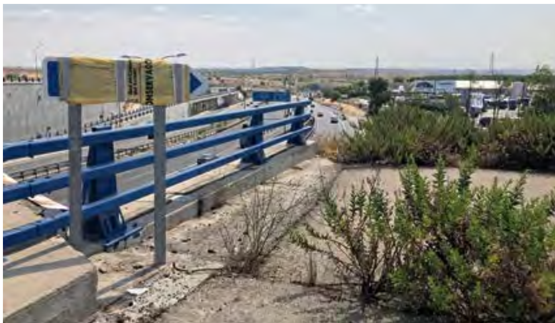
Un cartel tapado indica por dónde debería discurrir la vía de acceso a la A-3.
