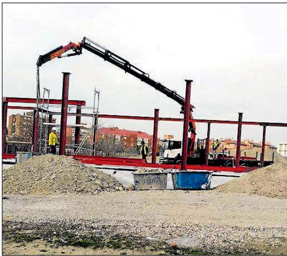
Los trabajos avanzan a buen ritmo.
